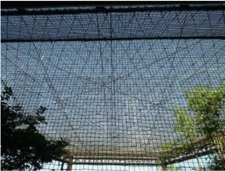
修繕後の里山館ケージ金網 (平成30年8月23日撮影)
